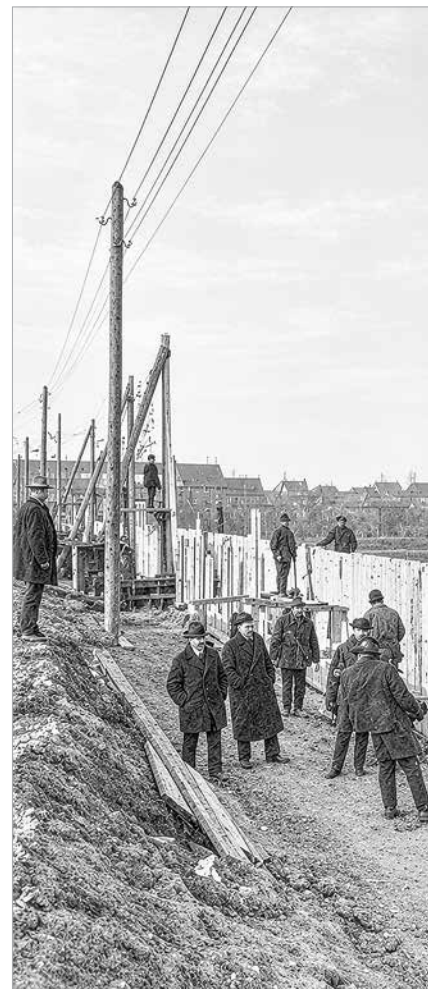
Száfalak között süllyesztik a nyomócsöveket a földminchiárom méter magasságból érkezik a tiszta víz irányába.
